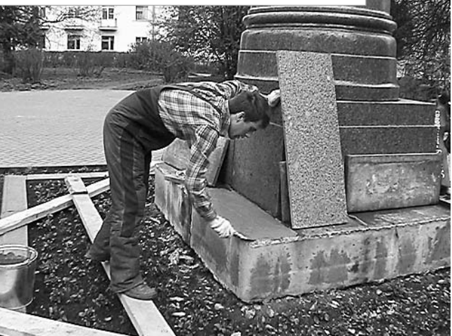
Ремонт памятника маршалу К. К. Рокоссовскому
